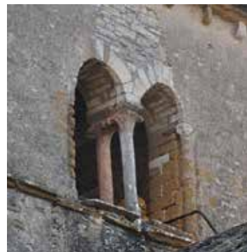
Colonnettes des baies géminées du clocher au toit en bâtière de l'église d'Ozenay.
