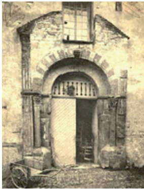
Etat antérieur à 1913 : on aperçoit la fenêtre ouverte au XVII e et le très mauvais état des pilastres et colonnes non encore repris au ciment. L'ancienne église est alors une fabrique de chaises...
