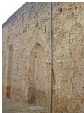
Vestiges de l'église du XII e siècle : les fenêtres romanes occultées, les contreforts arrachés (à l'emplacement de la descente des chéneaux) et, au sommet, le bel appareillage régulier.
