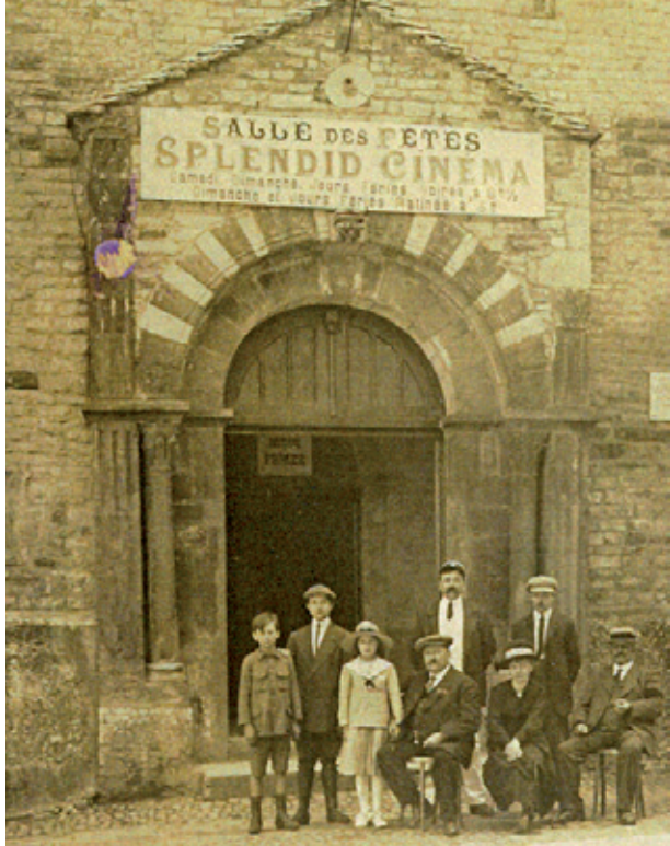
Le portail a été rénové, la fenêtre XVII e obturée... L'église est devenue un cinéma.
