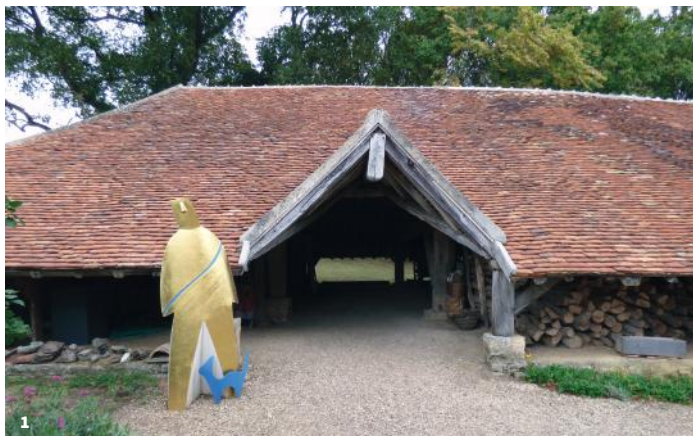
1. Halle de séchage de la tuilerie de Lancharre, avec une œuvre de Bernard Delaval © PAH
