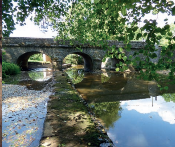
La vallée possède de nombreux ponts permettant le franchissement du cours d'eau. Au hameau de Vitry-lès-Cluny à la Vineuse-sur-Frégande, ce pont a été construit en 1851. En contrebas, un lavoir profite des eaux de la Gande.
